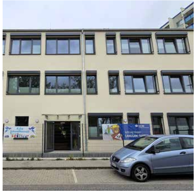
Nach dem Umzug der Kindertagesstätte in das neue Gebäude wird der dann nicht mehr benötigte Interimsbau wieder entfernt. / Foto: ak
