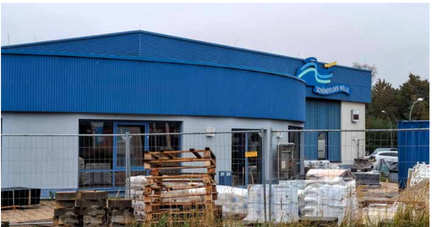
Die Sanierung der Schönefelder Schwimmhalle ist nach wie vor im Gange. / Foto: jm
