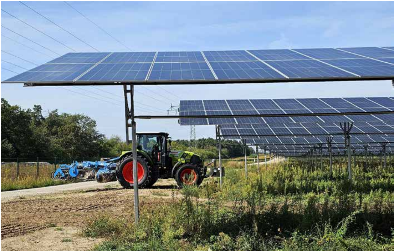
Am 08.09.2026 wurde die Agri-PV-Anlage in Betrieb genommen. / Foto: ak
