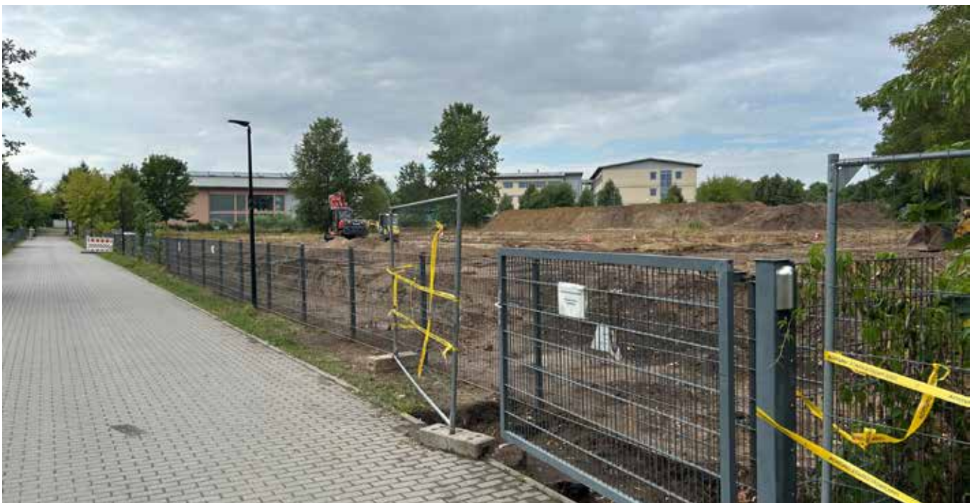
Baustelle Bolzplatz (Samariterweg) / Foto: R. Sperling
