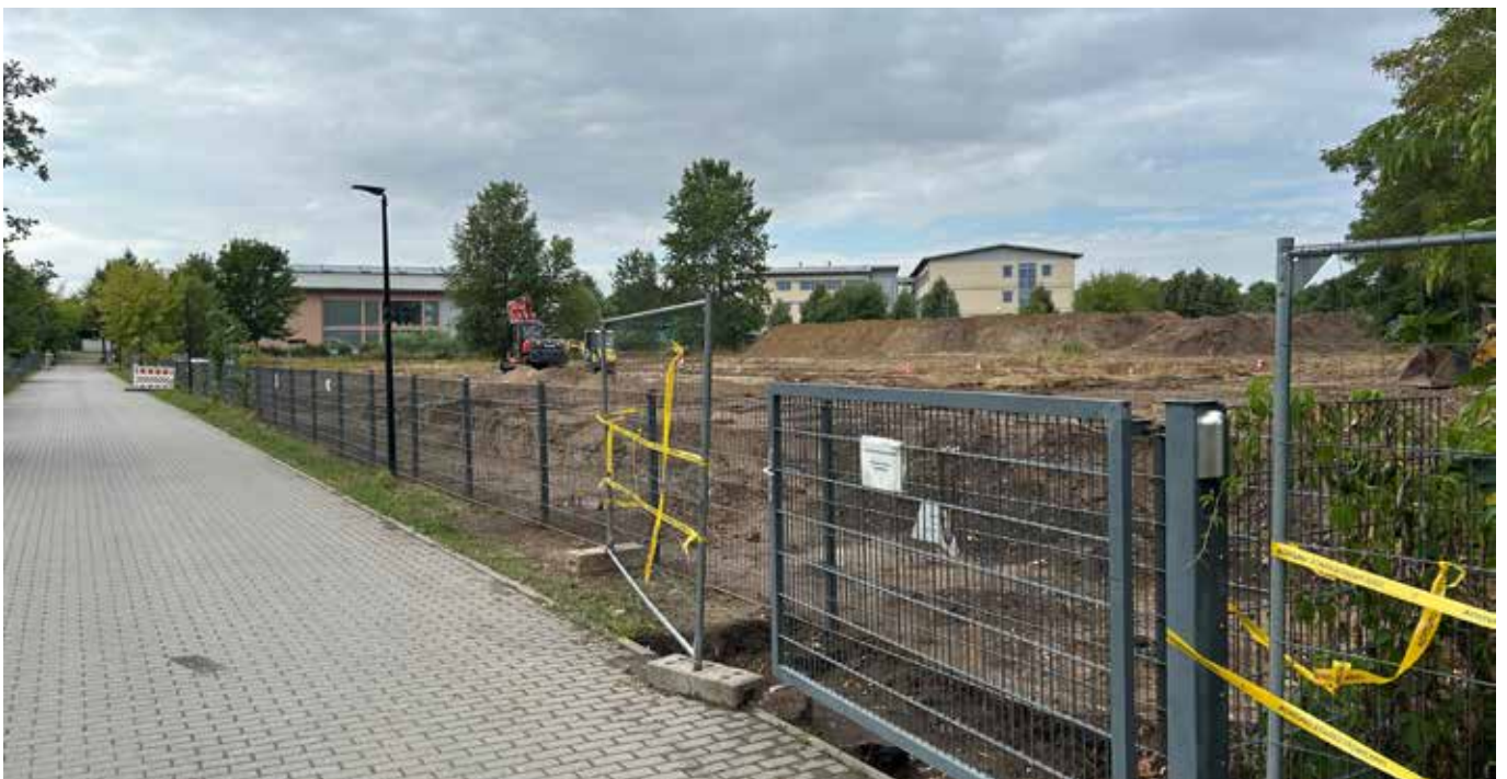
Baustelle Bolzplatz (Samariterweg) / Foto: R. Sperling
