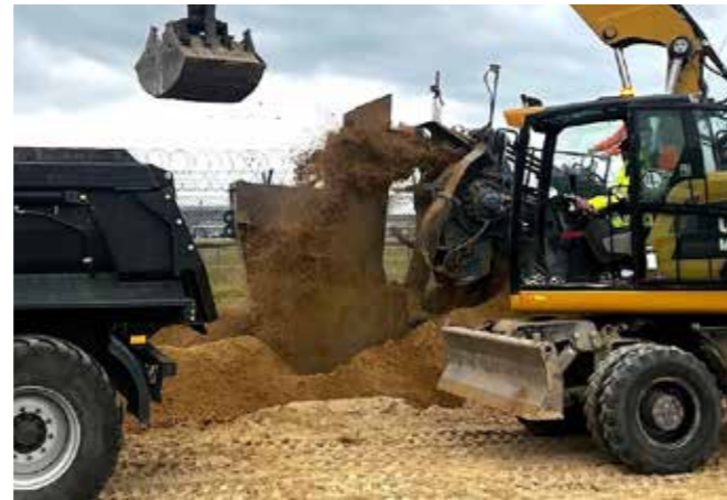
Bauarbeiten an der Südbahn / Foto: Gemeinde Schönefeld
