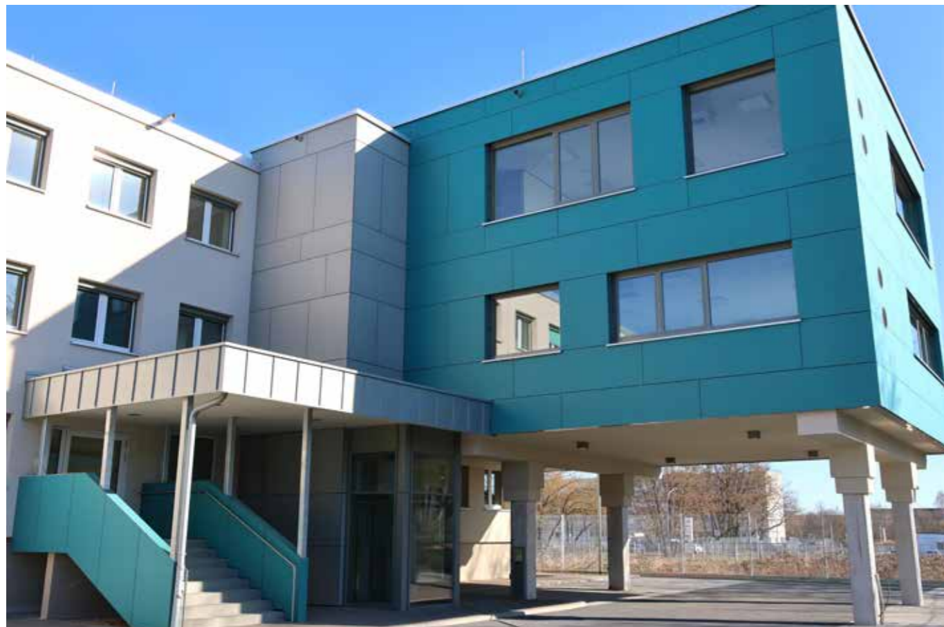
Barrierefrei und mit moderner technischer Infrastruktur ausgestattet: Das neue Bürgerhaus am Schwalbenweg / Foto: jm
