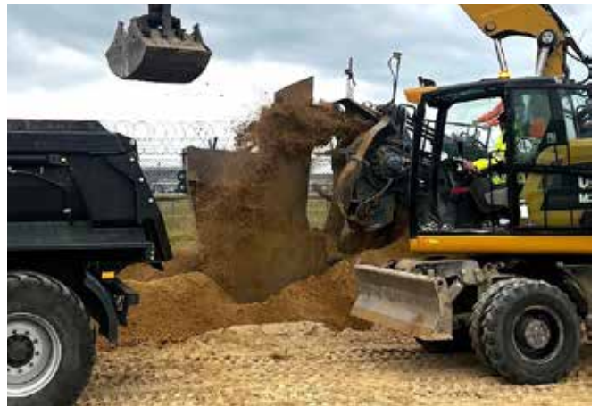
Bauarbeiten an der Südbahn / Foto: Gemeinde Schönefeld
