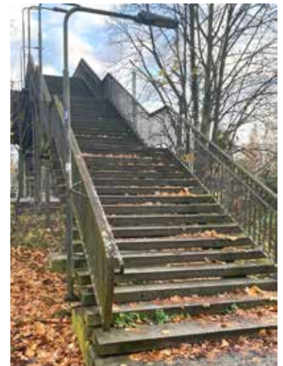
Fußgängerbrücke über die Bahnlinie nun ohne Fahrradschiene
