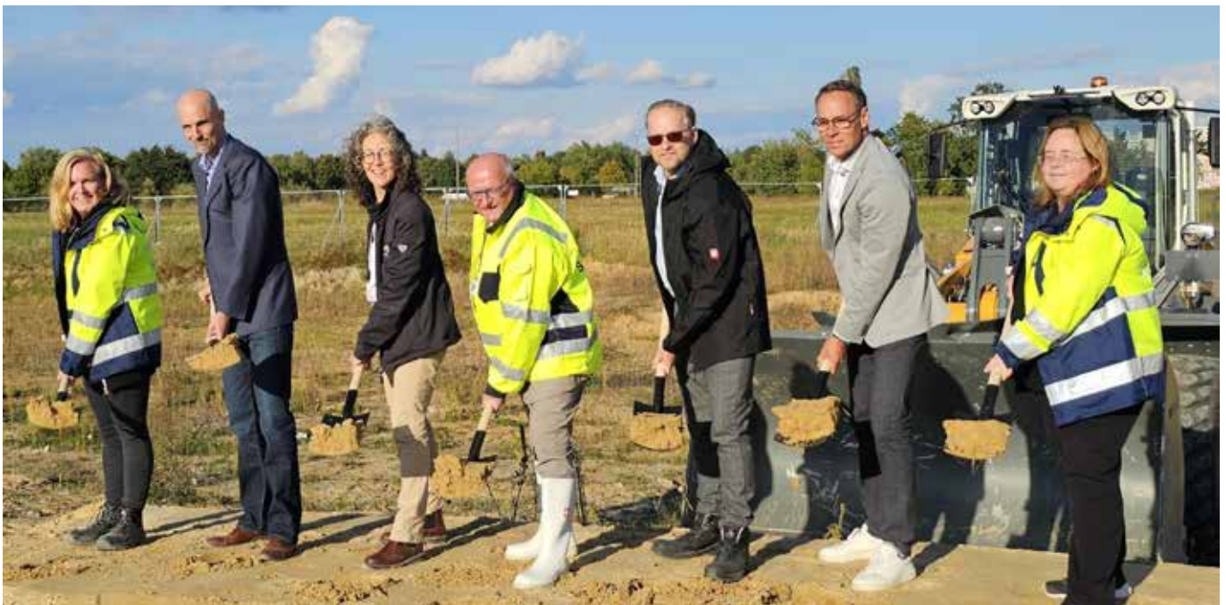
V.l.n.r.: N. Berghof (Sachbearbeiterin Tiefbau), T. Schulz (Geschäftsführer PST GmbH), S. Bley (Verbandsvorsteherin MAWV), C. Hentschel (Bürgermeister Gemeinde Schönefeld), M. Matheis (Abteilung Vertrieb e.distherm), V. Brühl (techn. Bereichsleiter STRABAG AG) und A. Schwuchow (Sachgebietsleiterin Tiefbau und Infrastruktur) beim symbolischen Spatenstich für die verkehrstechnische Erschließung des Plangebiets Schönefeld Nord. / Foto: Gemeinde Schönefeld /
