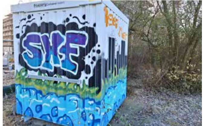
Technikcontainer am Teich Wehrmathen / Foto: jm
