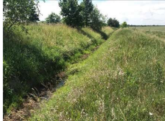
Foto 6: Entwässerungskanal, Blick nach Süd
