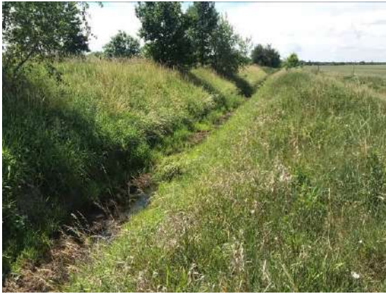
Foto 1: Entwässerungsgraben, Blick von Nord
