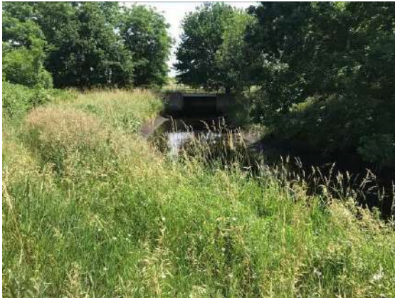
Foto 7: Schleuse am Entwässerungskanal
