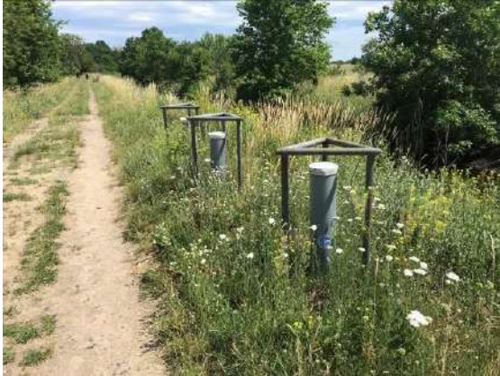
Foto 5: GWM am Entwässerungskanal
