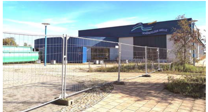
Die Sanierungsarbeiten in der Schönefelder Schwimmhalle sind in vollem Gange. / Foto: sos
